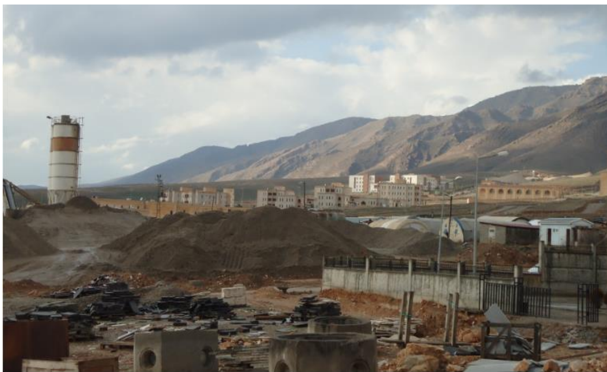
Figure 25 : Le nouvel Hasankeyf, en chantier. En arrière-plan, les bâtiments déjà construits.
