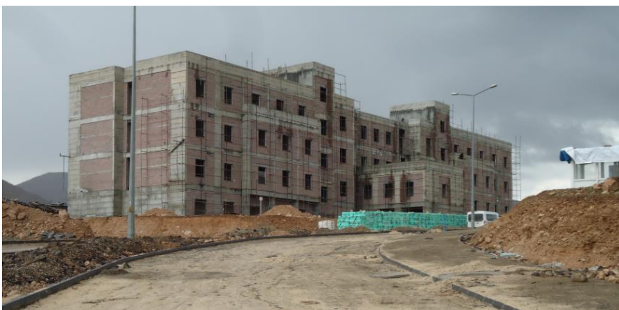
Figure 28 : Hôpital en construction
