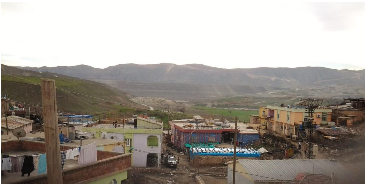
Figure 67 : Vue sur le barrage depuis le village de Koçtepe, en amont. Le barrage, malgré sa taille imposante, se fond bien dans le paysage
