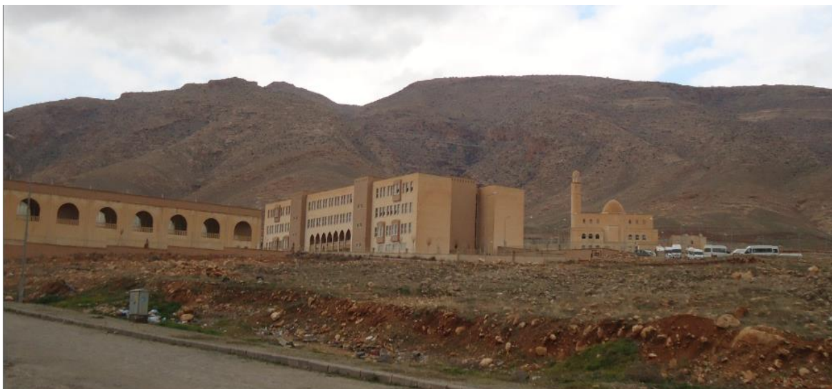
Figure 27 : école (gauche) et mosquée (droite)
