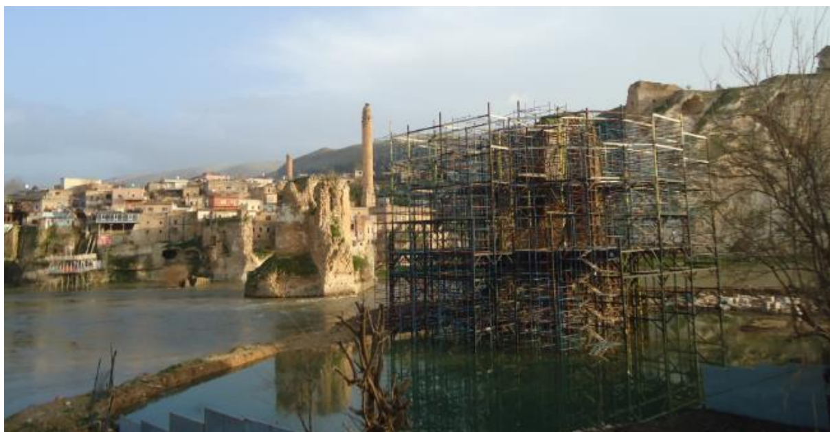
Figure 35 : L'un des deux pieds du pont est en rénovation, en vue de sa consolidation.
