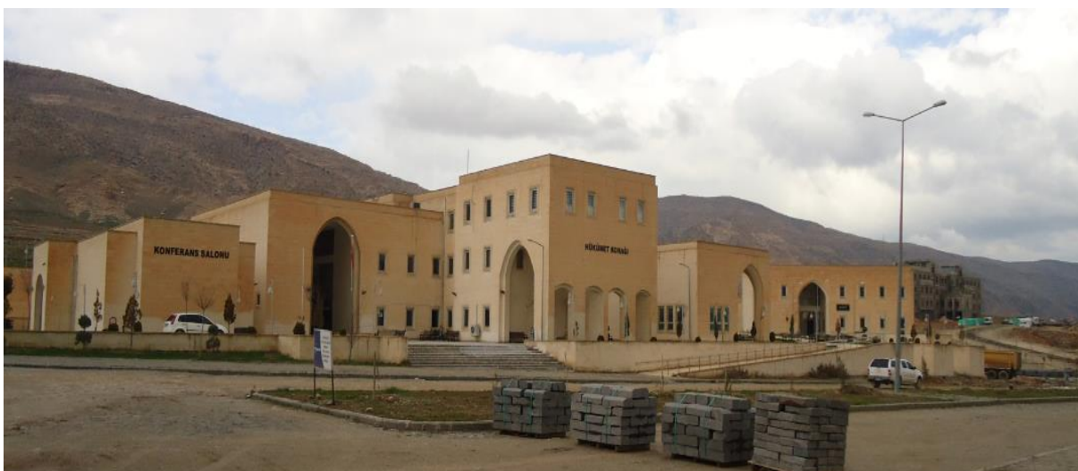
Figure 26 : Bâtiments administratifs : Salon de conférence, Sous-préfecture (Kaymakamlık), Mairie, Centre de poste
